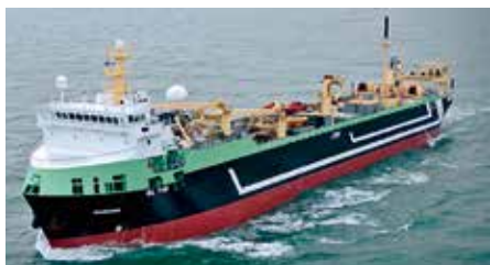
Společnost GEA vybavila FV Margiris kaskádovým chladicím zařízením pracujícím s dvojicí chladiv NH 3 /CO 2 . Trauler je druhým největším svého druhu na světě.
