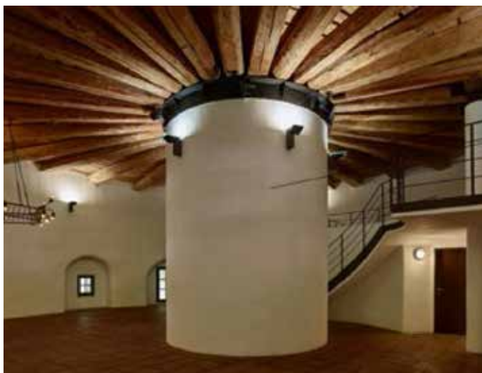
Pevnost Kufstein, interiér v Císařské věži (Kaisersturm)
