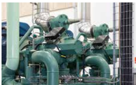
Každá čpavková kompresorová jednotka ACP je monitorována třemi moduly BITZER IQ
