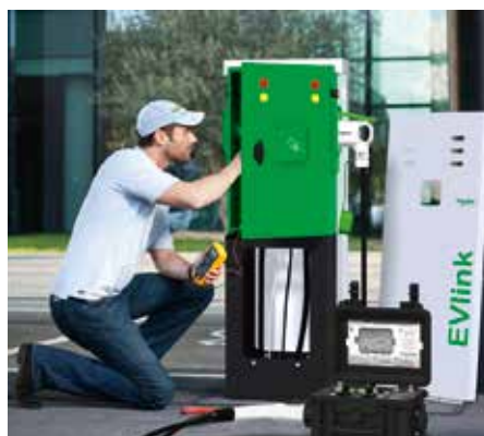
Snadná údržba nabíjecích stanic EVlink, foto Schneider Electric
