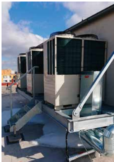
Realizace: GT Energy s.r.o.
