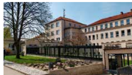
Realizace: GT Energy s.r.o.
