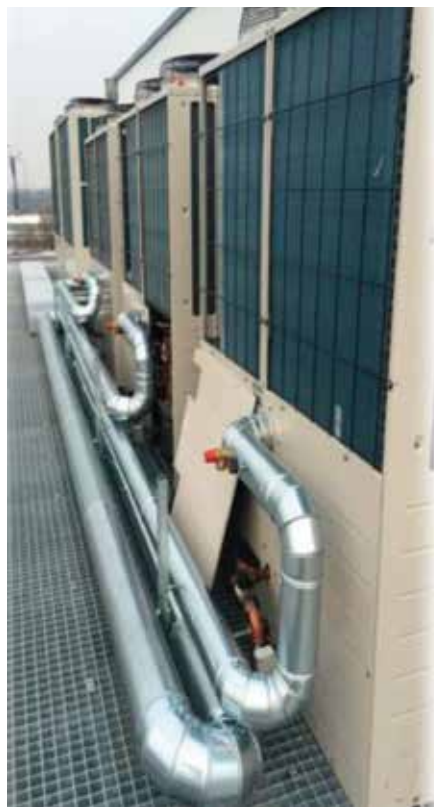
Realizace: GT Energy s.r.o.
