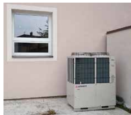
Realizace: GT Energy s.r.o.
