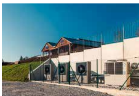
Realizace: GT Energy s.r.o.
