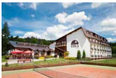
Realizace: GT Energy s.r.o.
