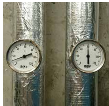
Realizace: GT Energy s.r.o.
