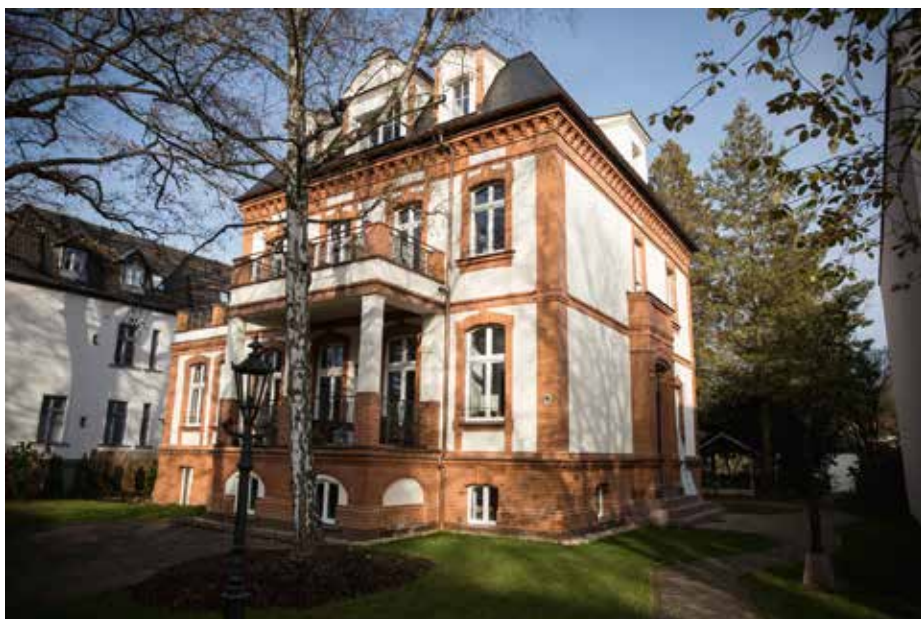
Modernizace vytápění tepelným čerpadlem funguje ve většině případů bez problémů (BWP)
