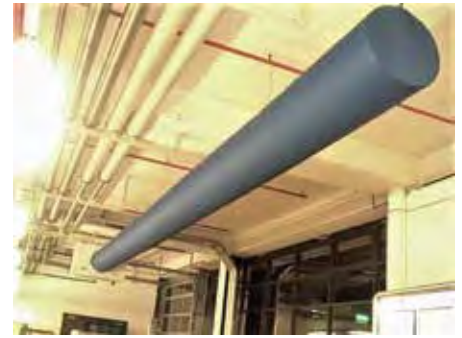
Bezprůvanový rozvod temperovaného vzduchu textilními rukávci
