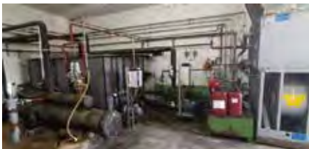
Staré čpavkové chladicí zařízení z doby před rokem 1990 již neodpovídalo současnému stavu techniky
