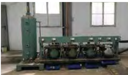
U stávajícího chladicího zařízení s chladivem R404A se už nedalo spoléhnout na bezporuchovost provozu (Störanfälligkeit war sehr hoch), zejména v horkých letních měsících
