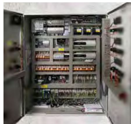
Řídicí skříň dodávaná společností Fischer s řídicí technologií Carel pCO a monitorovacím systémem Carel Boss
