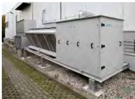
Individuálně navrženo podle požadavků projektu a realizováno společností [CF] Systems: Venkovní kondenzační jednotka s výkonem 135 kW NK – kompresor Bock HG88, kondenzátor Güntner a řídicí technika Carel.
