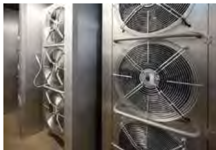
Výparníky kuchyňských šokových chladičů vybavené elektronickými expanzními ventily Carel E2V
