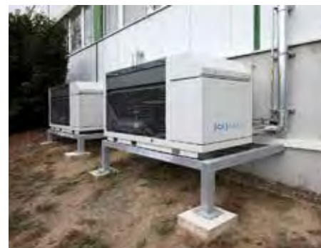
Dvě kondenzační jednotky Easy L poskytují celkový chladicí výkon 70 kW pro kuchyňské šokové chladiče
