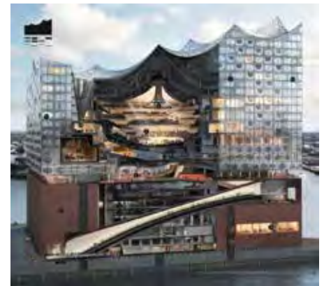
Elbphilharmonie od architektů Herzog a de Meuron, Basilej / bloomimages
