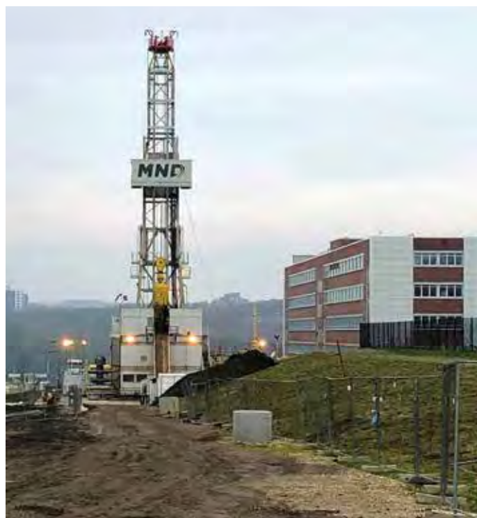
Vrtná souprava v bývalém areálu závodu Opel v Porůří ve městě Bochum
