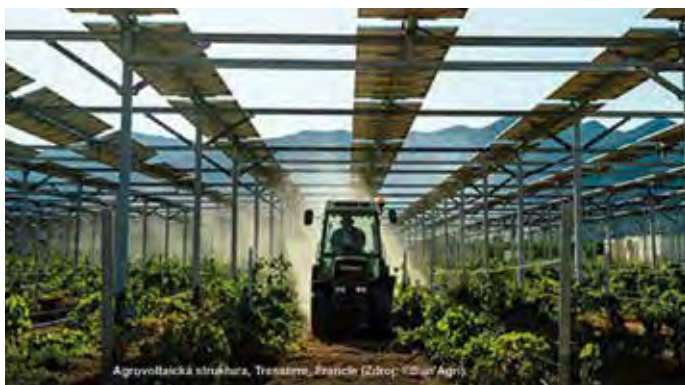
Agrovoltaická struktura, Tresserre, Francie (Zdroj: ©Sun'Agri)
