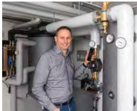
Výkonný ředitel společnosti Taconova Ralph Seewald ve své kotelně, obklopen nově instalovanými výrobky Taconova, od stanice čerstoé teplé vody přes odlučovač vzduchu a kalu až po topné oběhové čerpadlo TacoFlow2 eLink, které lze ovládat prostřednictvím chytrého telefonu
