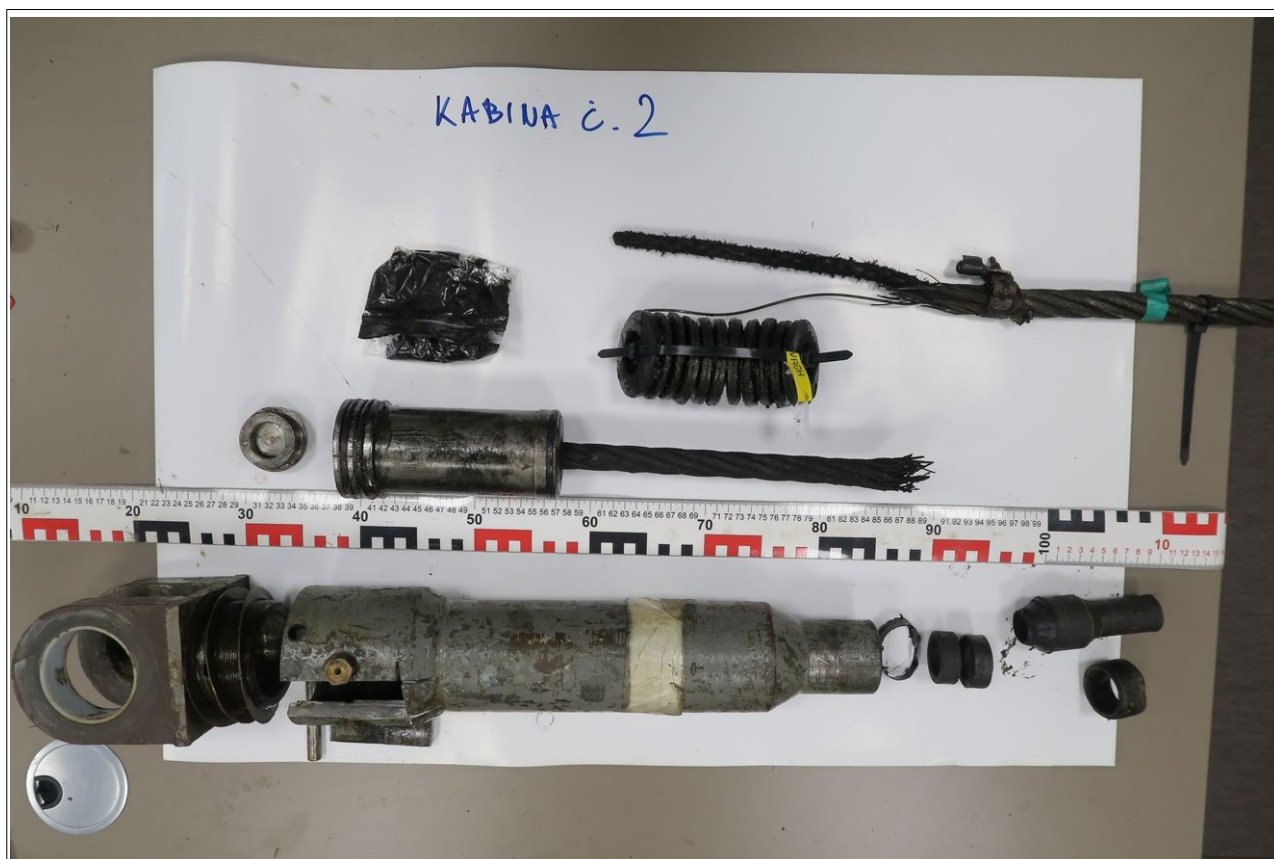
Obr. č. 7: Demontáž koncovky tažného lana vozu č. 2
