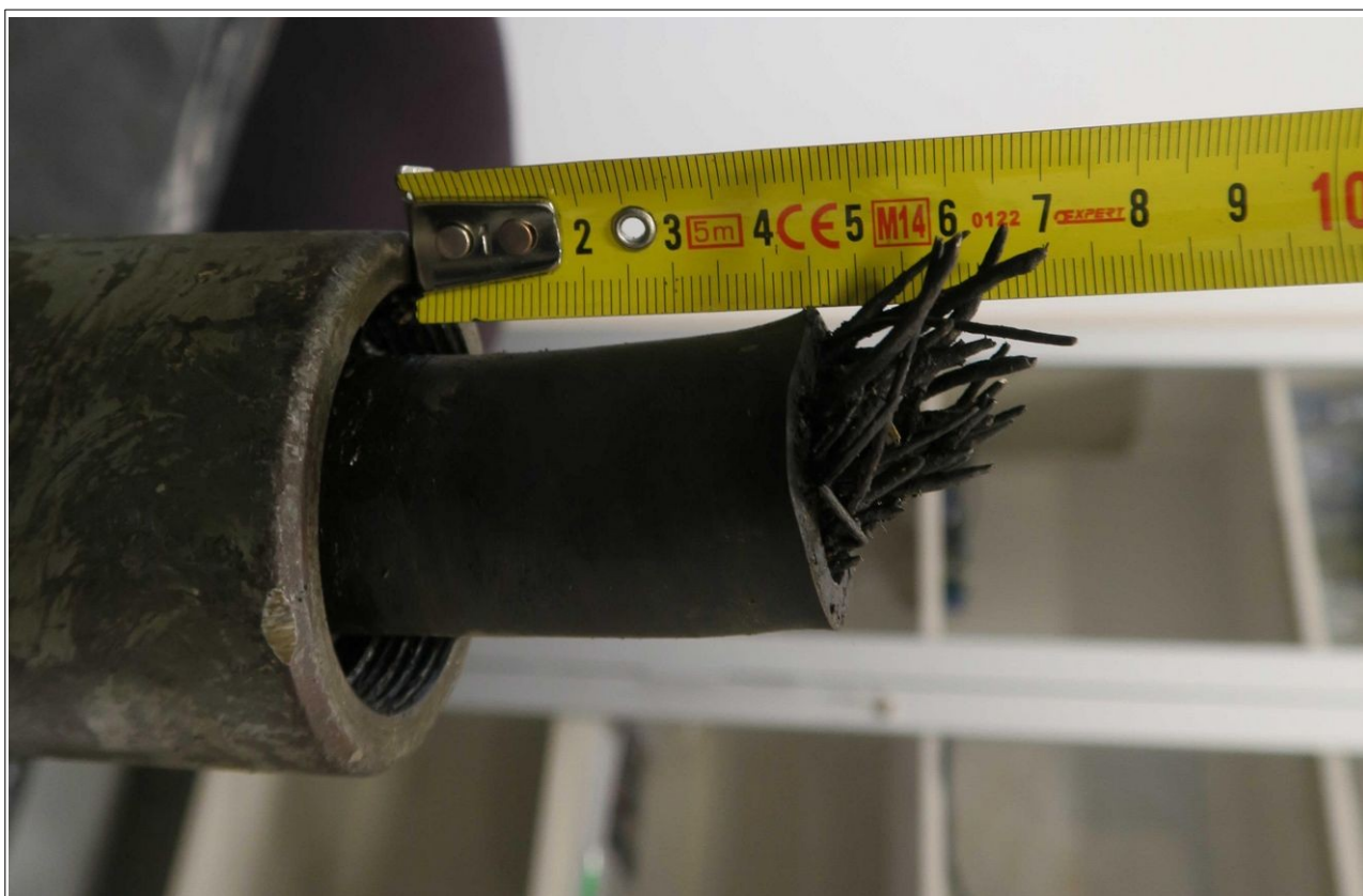
Obr. č. 3: Detail prasklého tažného lana v místě pouzdra koncovky
